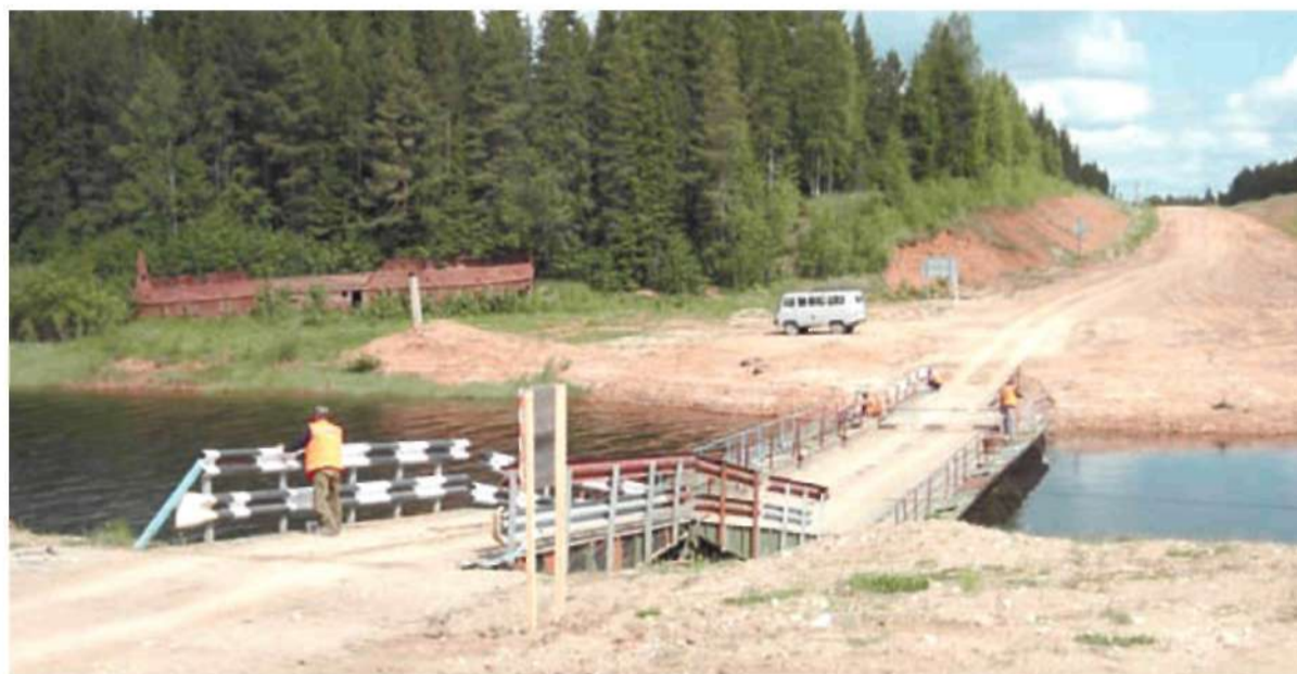
Наплавной понтонный мост через реку Кимжа
