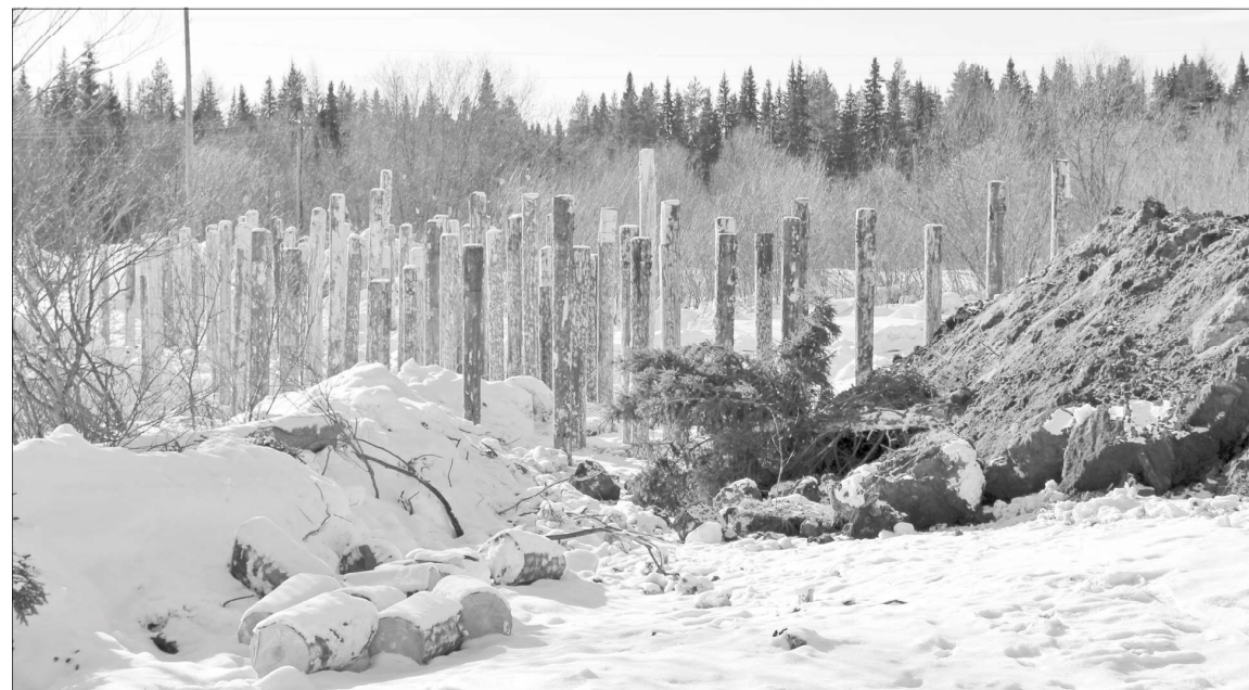
Забиты сваи для нового моста.
