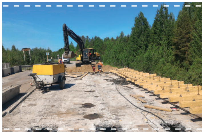
Ремонт моста через речку Пучуга на автодороге Усть-Вага – Ядриха
