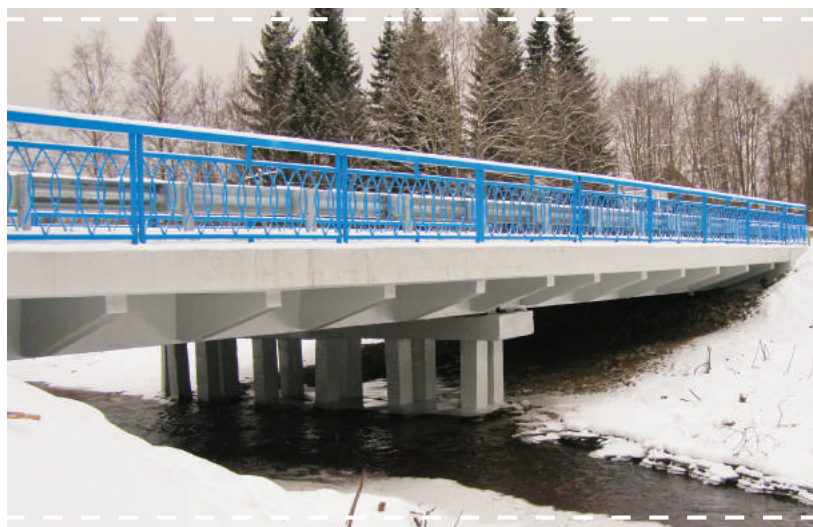
Надёжный и современный мост – украшение дороги. Мост через речку Чёрная в Котласском районе
