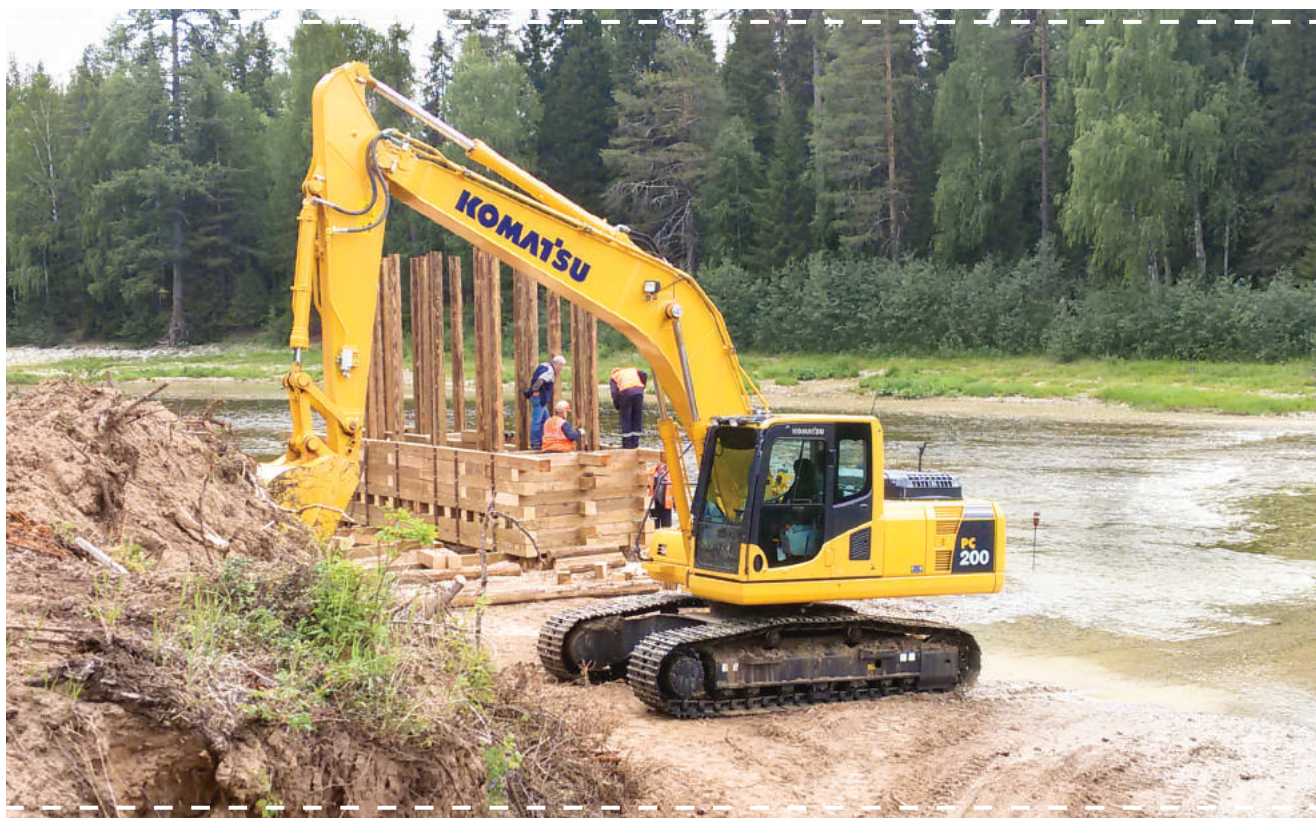
Через реку Ёжуга строится новый мост
