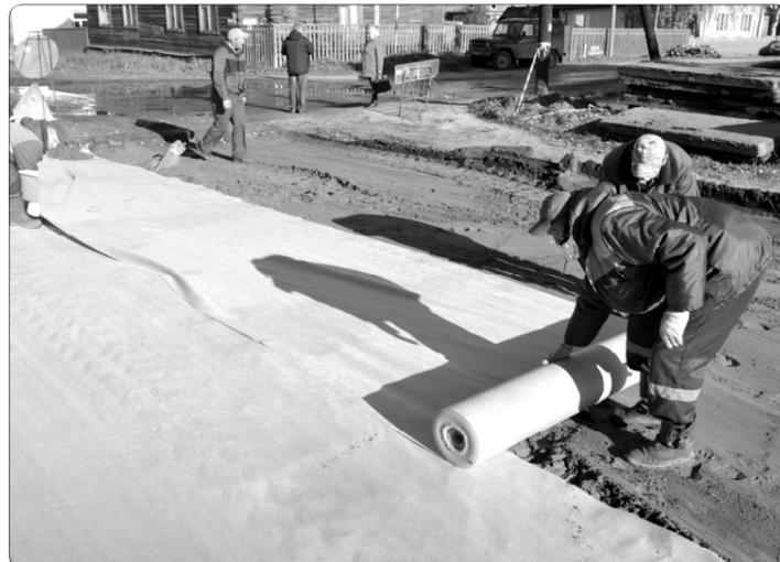
та дорожники начали раскатывать из рулонов белоснежный дорнит. Укладывали его участками, а затем засыпали песком. На объекте были задействованы трактор Т-170, КамАЗ и погрузчик.
