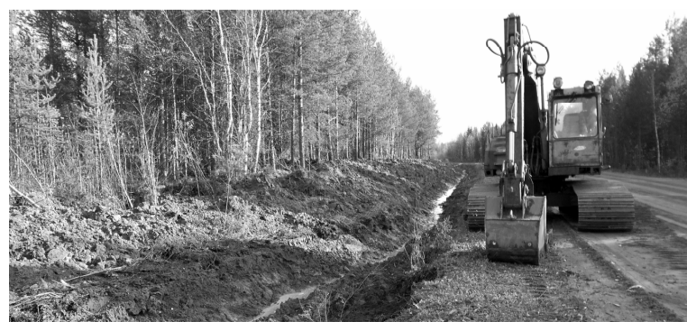
Оканавливание на дороге Каменка-Долгощелье
