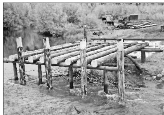
Мост через Попьюгу.
