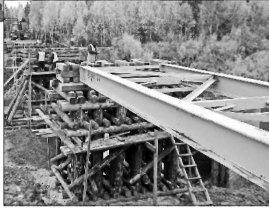
Мост через Ону.
