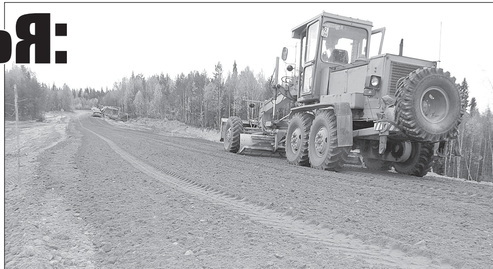
Профилирование с добавлением щебёночно-песчано-гравийной смеси.
