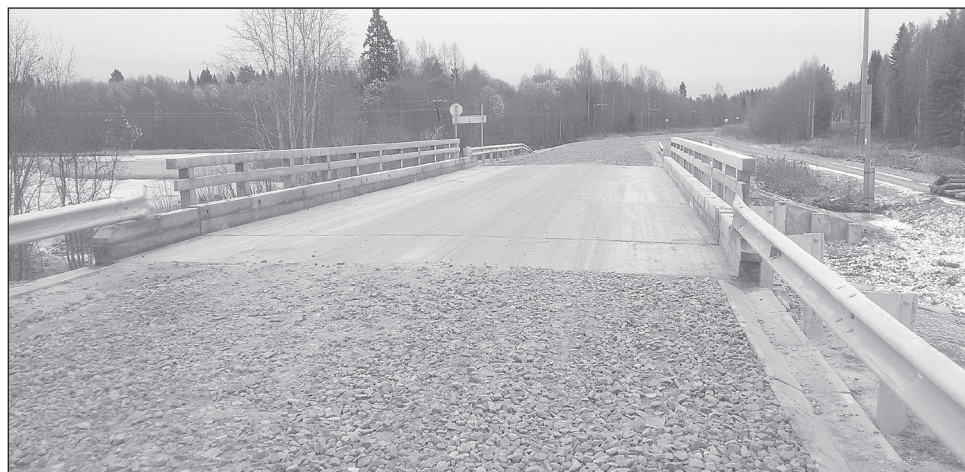
Новый мост появился через реку Малая Сотка.
