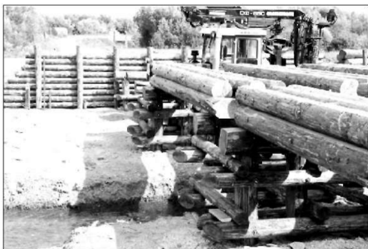
Строится мост через Еловую виску.
