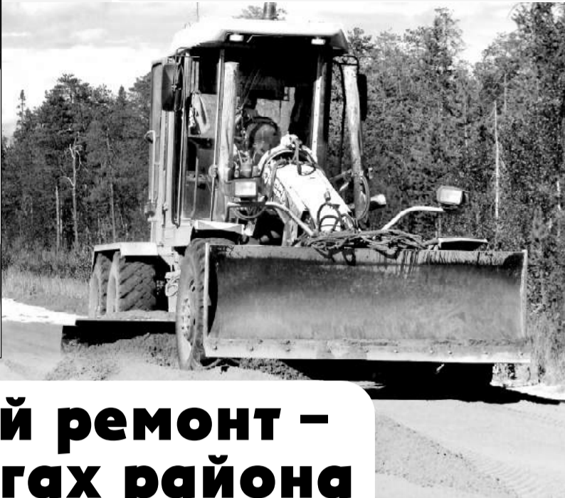
Ремонт дорожной одежды на участке дороги Архангельск-Мезень в районе Совполья
